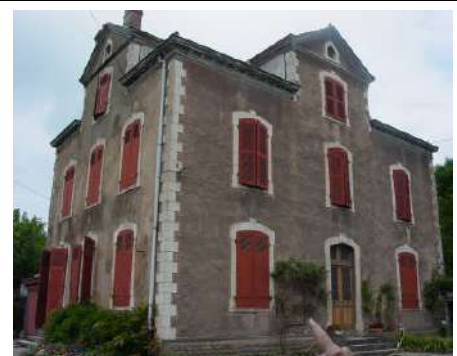
Volet sur une villa des ingénieurs
