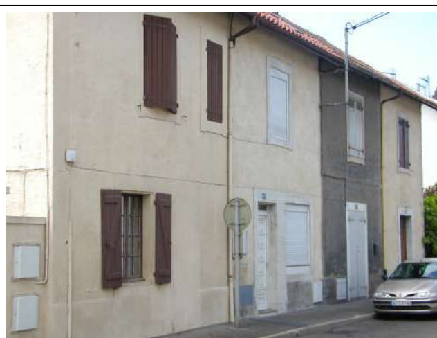
Façade en face de la rue des Pyrénées
