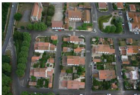
Vue aérienne de l'ensemble de maisons
